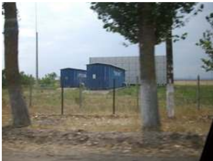
Stația de pompare a apei de la Suraia-Biliești
